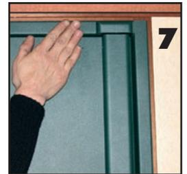
**Pour les portes 2 vantaux, mettre une vis en partie basse du 2<sup>ème</sup> montant, engonder la 2<sup>ème</sup> porte, aligner parfaitement les 2 vantaux (7) et mettez la 4<sup>ème</sup> vis en haut sur le 2<sup>ème</sup> montant.**
